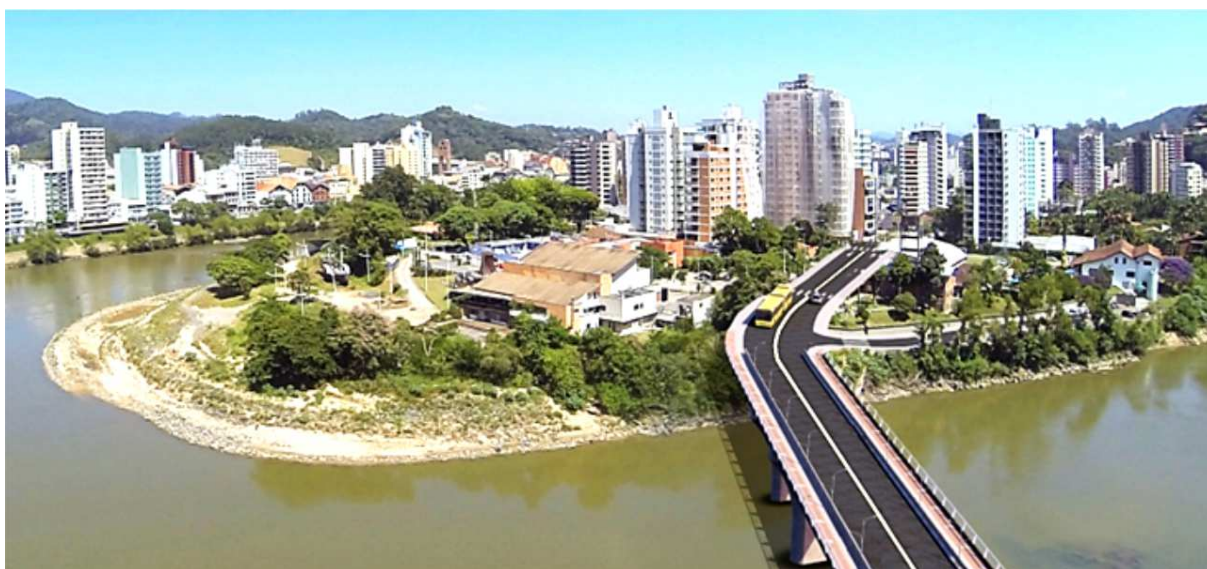
Figura - Projeto VP - 112 – Ponte Norte-Sul.
