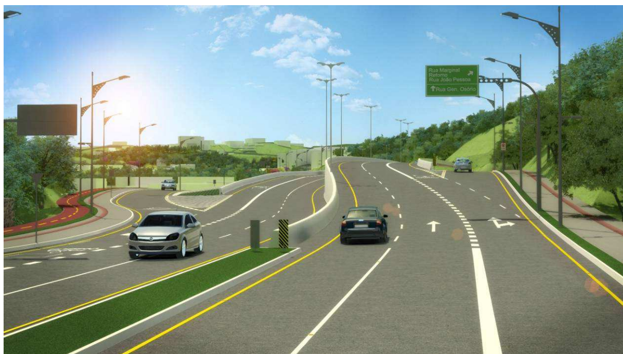
Figura - Projeto do Prolongamento da Rua Humberto de Campos – Obras em andamento.
